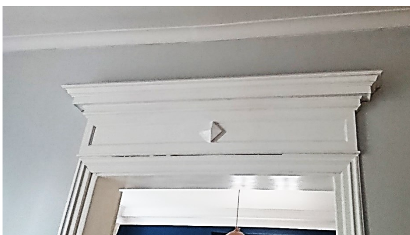
Zdj. 21 – Detal portali. Oba portale wyglądają tak samo. Widoczne na zdjęciu fasety są wtórne. Oryginalne fasety nie zachowały się w żadnym pomieszczeniu.
