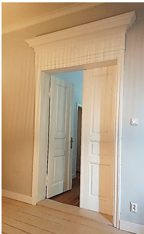
Zdj. 21 – Detal portali. Oba portale wyglądają tak samo. Widoczne na zdjęciu fasety są wtórne. Oryginalne fasety nie zachowały się w żadnym pomieszczeniu.
